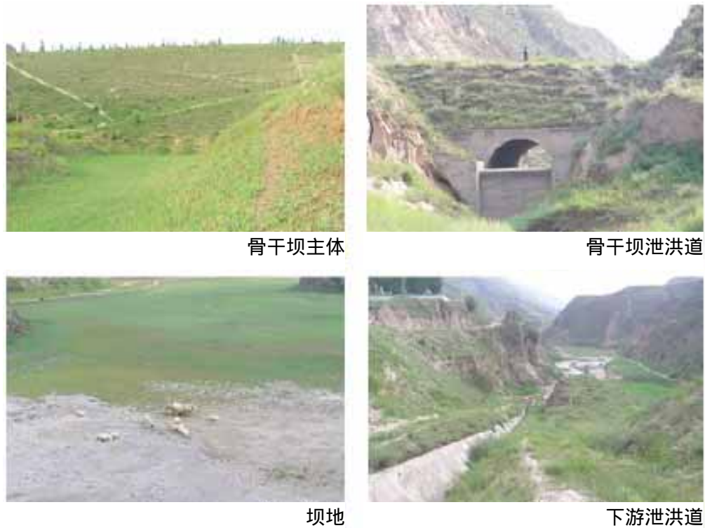
图 4.6. 淤地坝主体结构图
